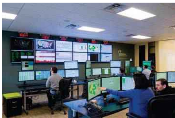
Рис. 4. Центр управления ветровыми электростанциями в Портланде (США)
